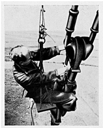
Bild 08: Einbau von Pardunen-Isolatoren am Funkturm eines Großsenders, Mindestbruchlast des Isolators etwa 450 t [24]
